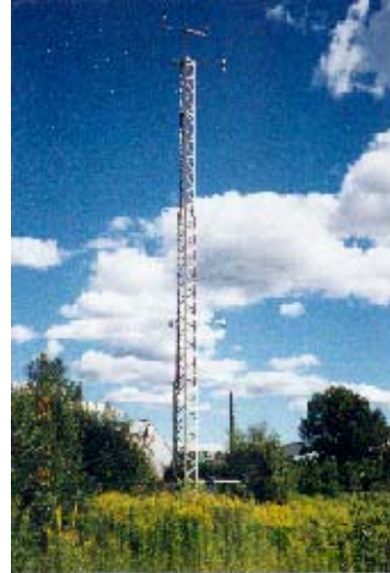
Vindmast vid Borås Energi
